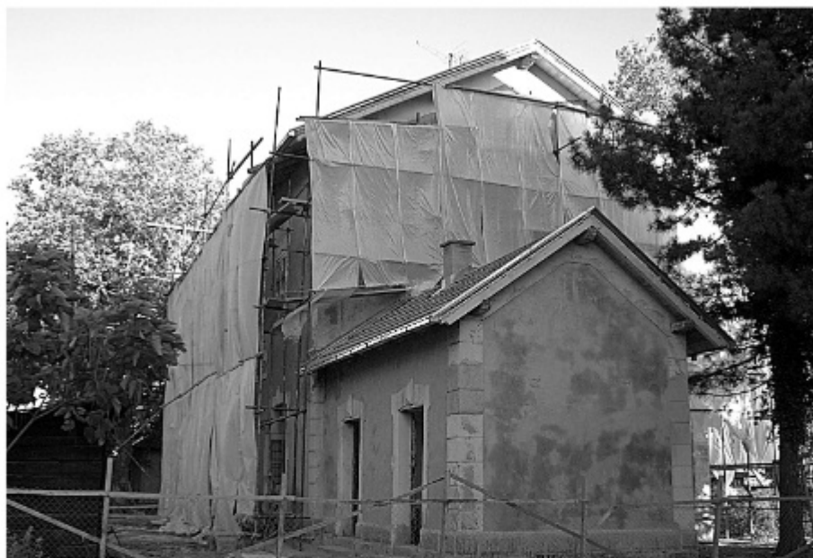
Реконструкција железничке станице у Аранђеловцу (радови у шоку)
