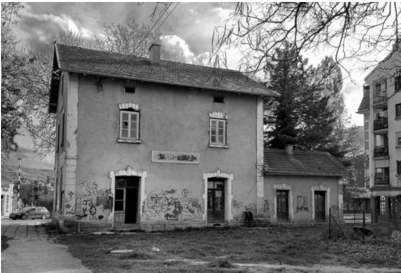
Садашњи изглед станичне зграде у Аранђеловцу
